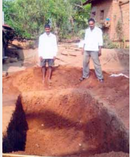
Toilettenbau bei Familie Souz
